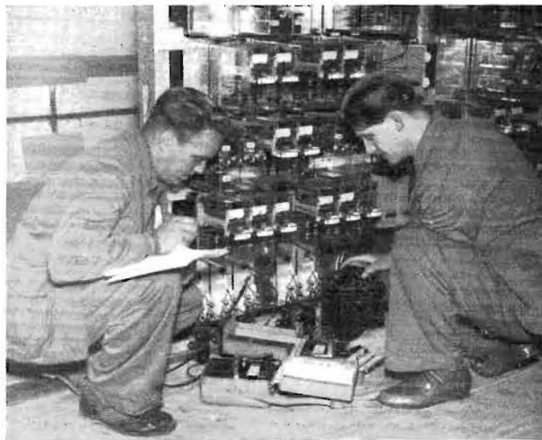
Signalförman Hans Rundblad och signalmontör Bror Eriksson ställa in spårströmmen i spårledning vid Alvik.
