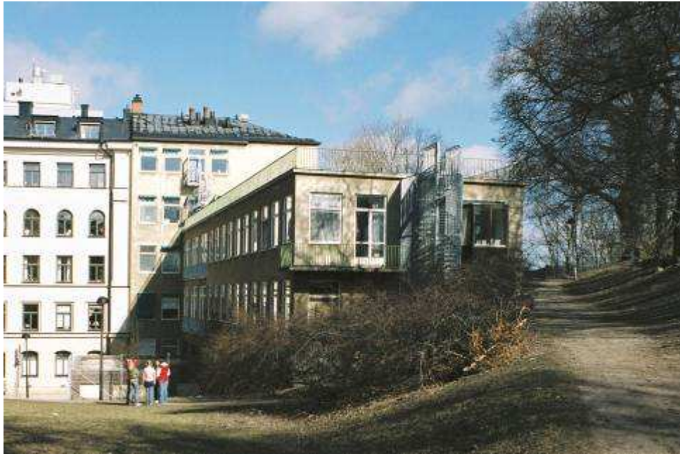
9 Institutet för organisk kemi och biokemi vid Stockholms högskola, ark. P. Hedqvist 1938–39. Tillbyggnad söderut för högskolan 1957–59. Fasader mot söder. Till höger i bild syns gångväg upp till Observatoriekullen.
