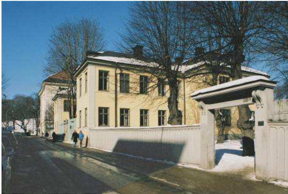
14 Malmgården Schefflerska palatset, 1699–1701. Fasader mot söder och planket som avgränsar gårdens park (Spökparken) mot Drottninggatan. 14 a och 14b är ett lusthus respektive en ekonomibyggnad ursprungligen från 1700-talet, ombyggda under 1800-talet.
