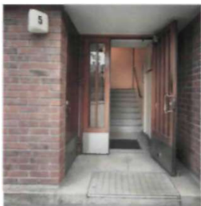
Indraget entréparti med port av ek.
