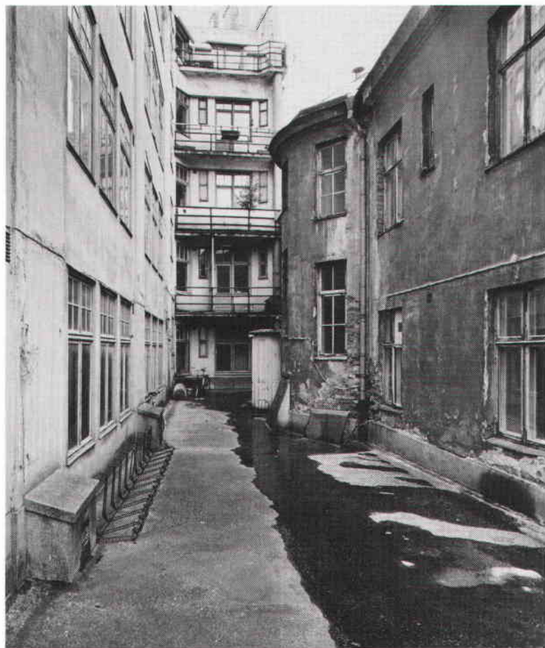
I fonden gårdsfasaden till Götgatan 7 med köksfönster och balkonger. Det långsgående röret till höger på balkongerna är sopnedkastet, använt som en arkitektonisk effekt. Foto Ingrid Wilken 1987. SSM.
