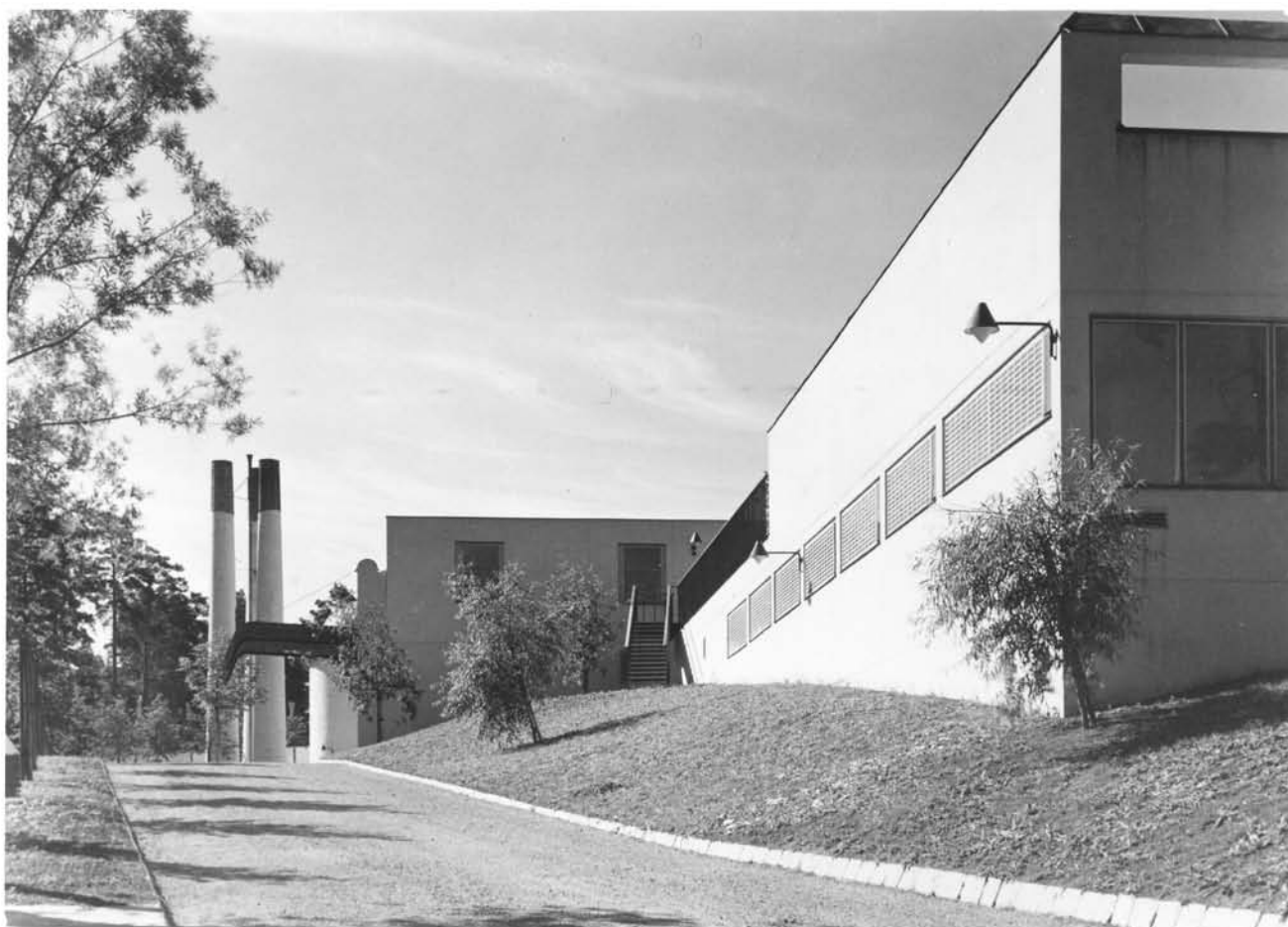
Skogskrematoriets östra fasad i ursprungligt skick. Foto C G Rosenberg 1940.
