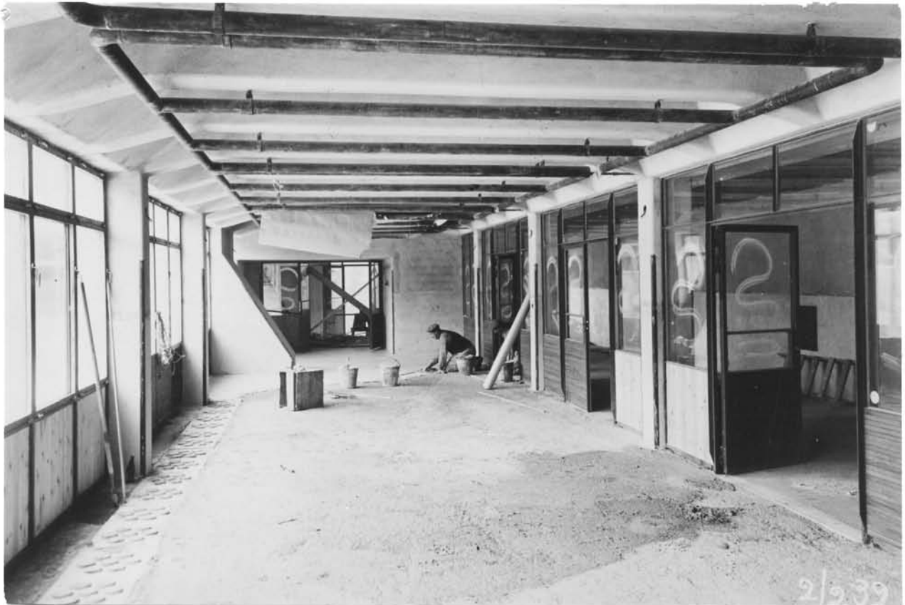
Det ursprungliga rum 85 - rum för dekorationsväxter (nu delat i flera mindre rum). På golvet utmed fönsterväggen syns de ursprungliga glasbetongöppningarna som gav dagsljus till rum 36. Öppningarna sattes igen 1967. Foto från norr 2.2 1939.
