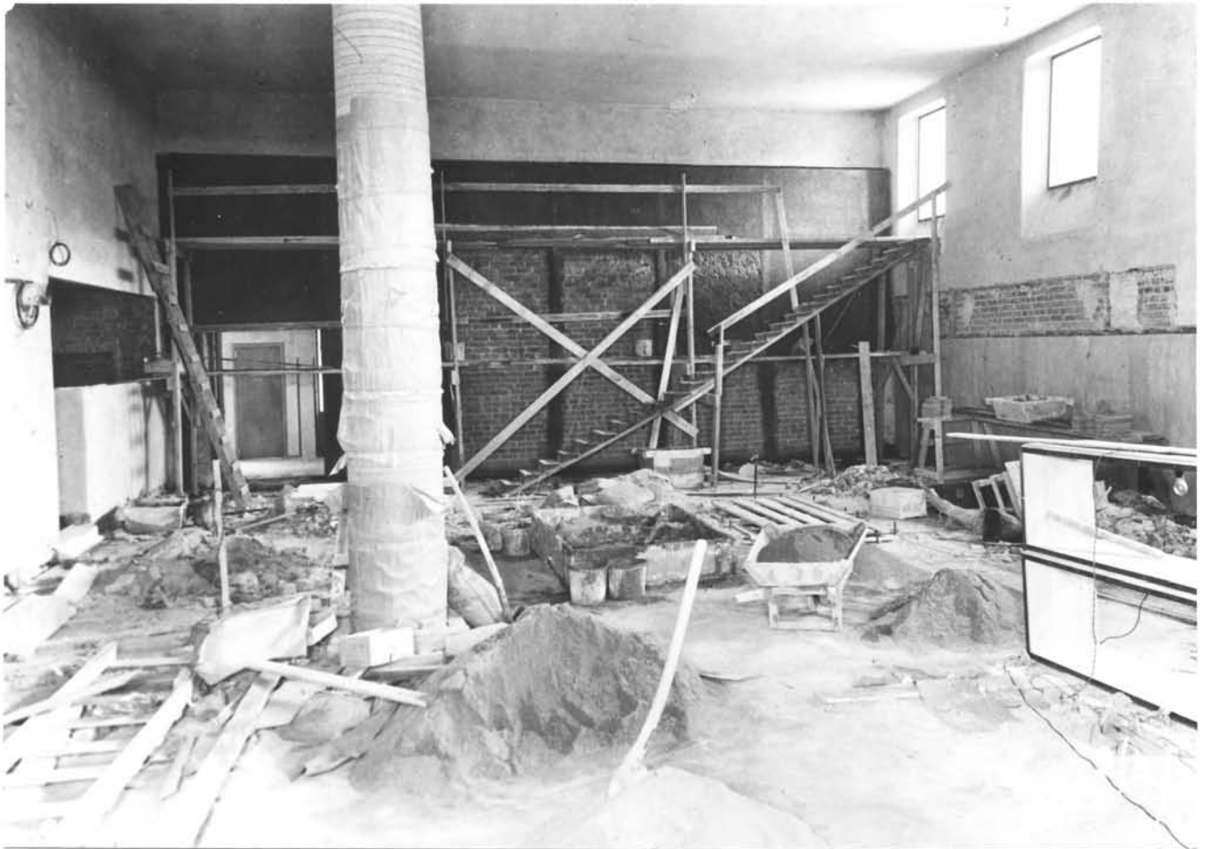
Hoppets kapell under uppförande. Foto från väster 2.2. 1939.
