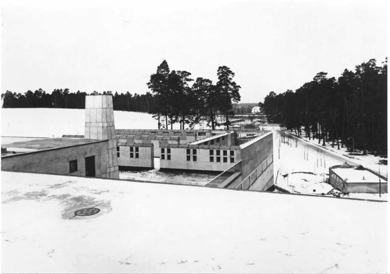
Skogskrematoriet med dess kapell under uppförande med urngårdarna och nere t.h. toalettbyggnaden. I förgrunden syns den öppning med glasbetong som gav dagsljus till rum 77. Öppningen sattes troligen igen 1964. Foto från söder 2.2 1939.
