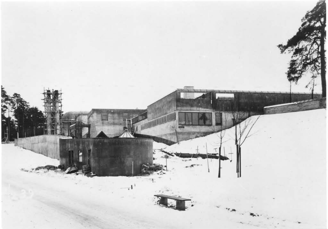
Skogskrematoriet med dess kapell under uppförande. I förgrunden syns toalettbyggnaden med den ursprungliga lanterninen till rum 60. Foto från norr 2.2 1939.
